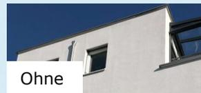
**Dachüberstände** und **Balkone** halten Fassaden zumindest teilweise trocken und senken das Risiko eines Befalls durch Algen oder Pilze. Zusätzlich bieten sie Schutz gegen direkten Witterungseinfluss und vermindern so auch den Biozidaustrag.
