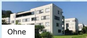
Eine Fassade, die dauerhaft durch andere Häuser oder Bäume **beschattet** ist, bleibt nach einem Regenereignis länger feucht, wodurch das Risiko eines Befalls durch Algen oder Pilze steigt.
