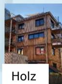
**Fassadenmaterialien** wie Glas, Klinker, Putz oder Holz sind unterschiedlich anfällig für Algen- und Pilzbefall. Auf Putz und Holz kommen oft große Mengen von Bioziden zum Oberflächenschutz zum Einsatz, die zum Beispiel bei Stein- oder Glasfassaden nicht notwendig sind.
