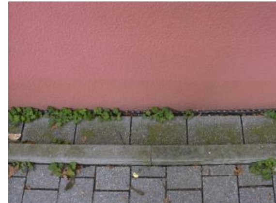
Fassade „nicht angeschlossen“
