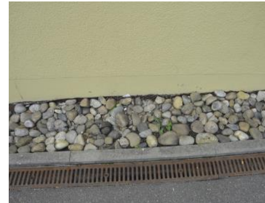
Fassade „nicht angeschlossen“
